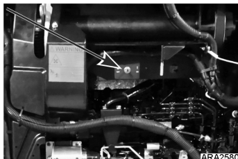
Рис. 8. Двухпозиционный выключатель питания микропроцессора
